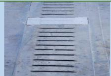
Se realiza cambio de rejillas de mármol que se encontraban deterioradas, esto con el fin de mejorar la seguridad del área y evitar incidentes con los visitantes CAMBIO DE LUCES
