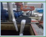
Se instaló una bomba de 2Hp en el sistema de captación de la Torre 3 para optimizar los tiempos de llenado de las albercas, mantener los niveles en los tanques y reducir el uso de carrotanques.
