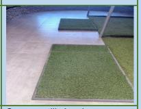
Se inicio el retiro de la mitad de la grama sintética para su reposición debido a que se encontraba deteriorada, igualmente se procede a la instalación de la nueva gran y su respectiva aplicación de polímeros.
