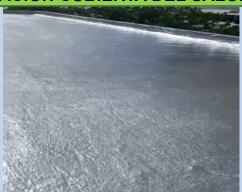
Se realizó impermeabilización a la cubierta del salón social, para evitar filtraciones y afectaciones durante la temporada de lluvias.
