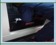
Se reemplazaron las 2 baterías de la subestación eléctrica de Torre 3, ya que estaban en mal estado, con el fin de garantizar un óptimo funcionamiento del sistema eléctrico.
