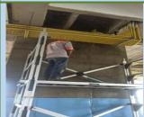
Se reparó una fuga en válvulas de alta presión en el piso 4 de la Torre 4 para asegurar el flujo de agua y prevenir daños mayores.
