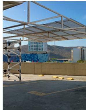
Se realizó la instalación de una nueva cubierta en policarbonato en el piso 4 de la Torre 1, como parte del mantenimiento correctivo de la estructura deteriorada por la exposición a cargas de viento y radiación solar. La intervención incluyó el retiro de la cubierta dañada, acondicionamiento de soportes, colocación de la nueva cubierta con fijaciones resistentes y sellado de juntas, garantizando impermeabilidad, seguridad y durabilidad conforme a los estándares técnicos de diseño.
