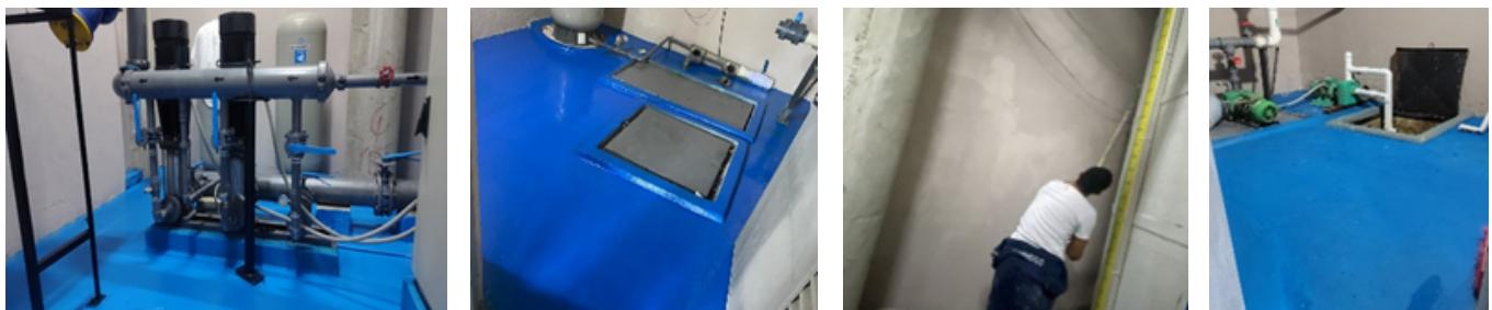
Intervención integral en los cuartos de bombas de todas las torres, ejecutamos actividades de mantenimiento correctivo y preventivo. Los trabajos comprendieron la preparación de superficies y la aplicación de pintura en pisos y paredes, conforme a las especificaciones técnicas establecidas. Asimismo, se realizó la limpieza especializada de ductos, garantizando la remoción de residuos, polvo y agentes contaminantes acumulados.
